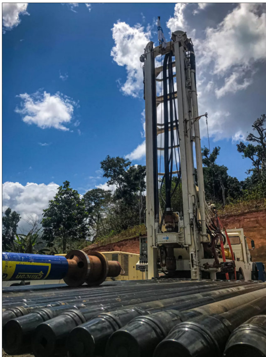
Un des forages de l'entreprise Sade
