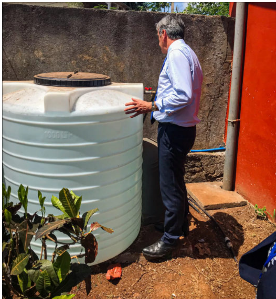
P. Vigier observe l'installation des cuves, notamment dans les écoles primaires qui ne se trouvent pas sur « le chemin de l'eau ».
