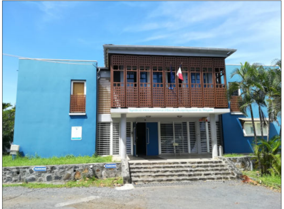
Le bâtiment du syndicat Les Eaux de Mayotte à Kawéni
