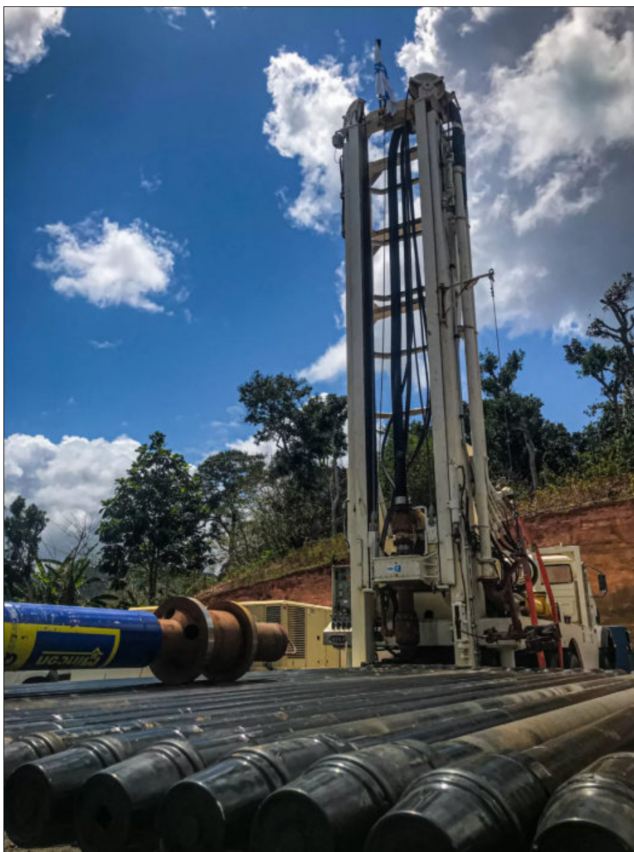
Le matériel pour forage gros diamètre est plutôt conséquent. L'entreprise Sade intervient aussi en Hexagone ou dans les autres DOM. À la Réunion par exemple, où les études souterraines sont menées depuis les années 60, le système hydrologique n'est pas le même. Là où Mayotte vise les 500M3/jour par forage, il est question de cette même production sur certains sites de nos voisins mais en une heure... Ça laisse rêveur !
