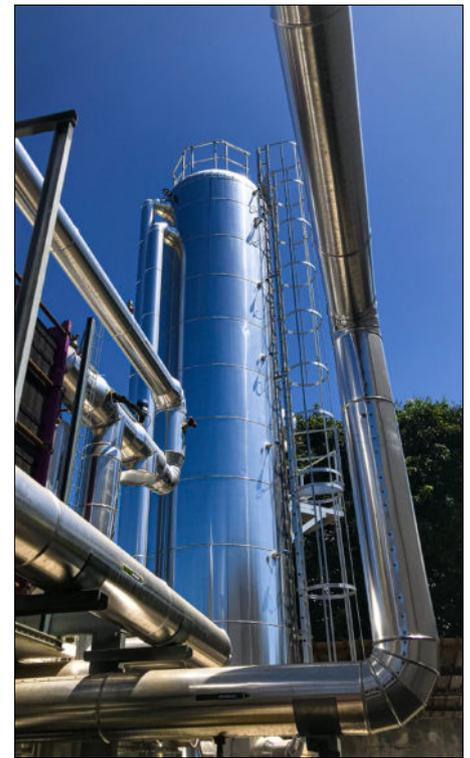
*Cette même centrale qui assure la production de chaud et de froid a ici une capacité de stockage de 30 000 litres d'eau glacée, utilisée dans le processus de refroidissement de certains produits*
