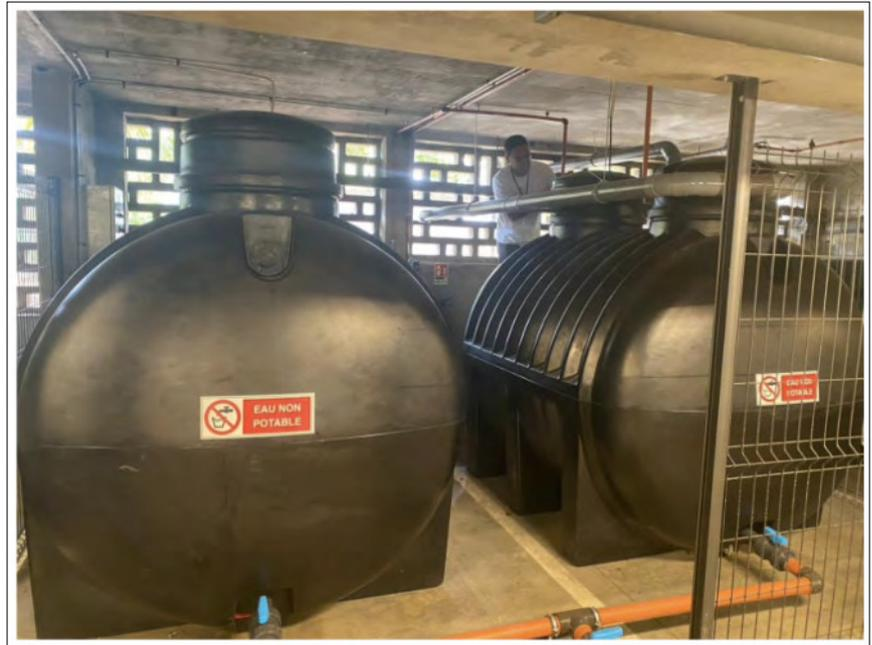
à 6 cuves de 6.000 litres de capacité. 36.000 litres d'eau non potable collectée permettent d'alimenter les sanitaires pour une autonomie d'au moins 2 jours en utilisation maxi. Huit pompes électriques pilotées automatiquement assurent le maintien en pression de fonctionnement des différents réseaux d'eaux potables et non potables. Elles fonctionnent par paire pour pallier les pannes et pour les économiser avec un système de détection de baisse de pression pour activer les pompes.
