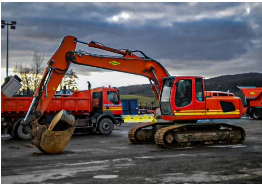
Colas sera en charge du chantier (archives)
