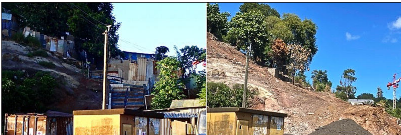
Le quartier de Talus 2 avant et après démolition
