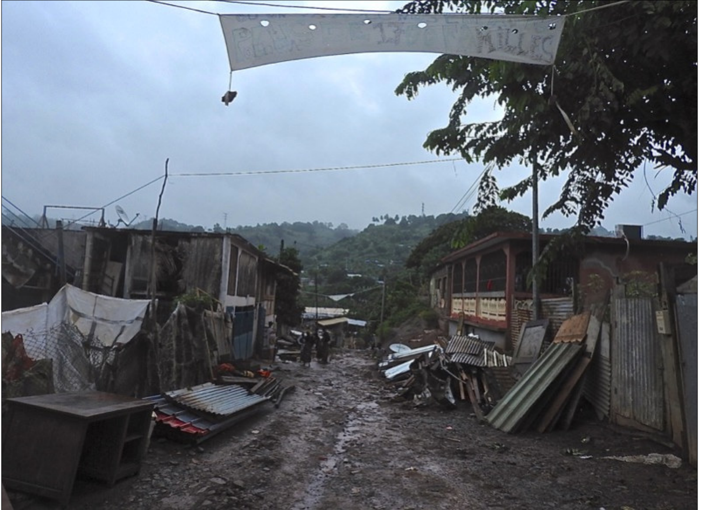
Démolition des tôles du quartier Jamaïque en mars 2021
