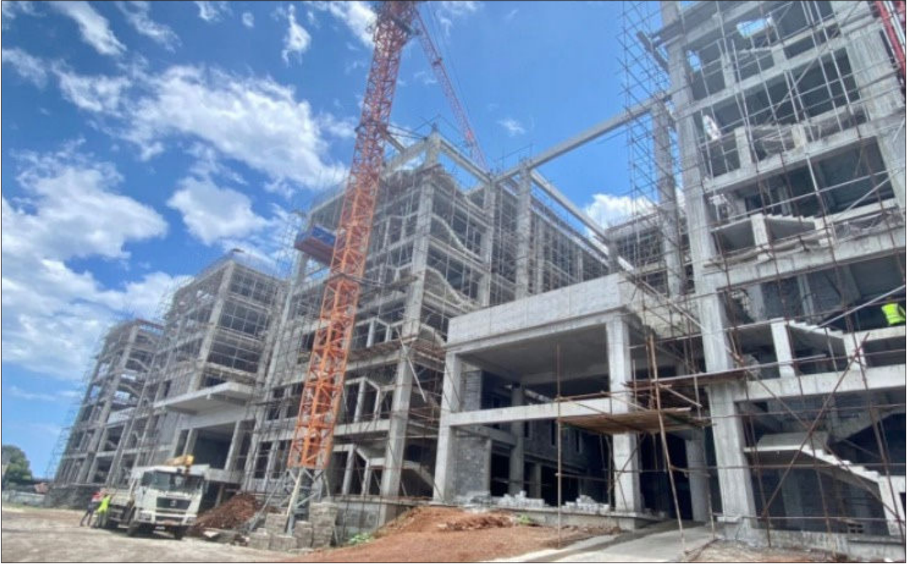
Le chantier en décembre 2022
