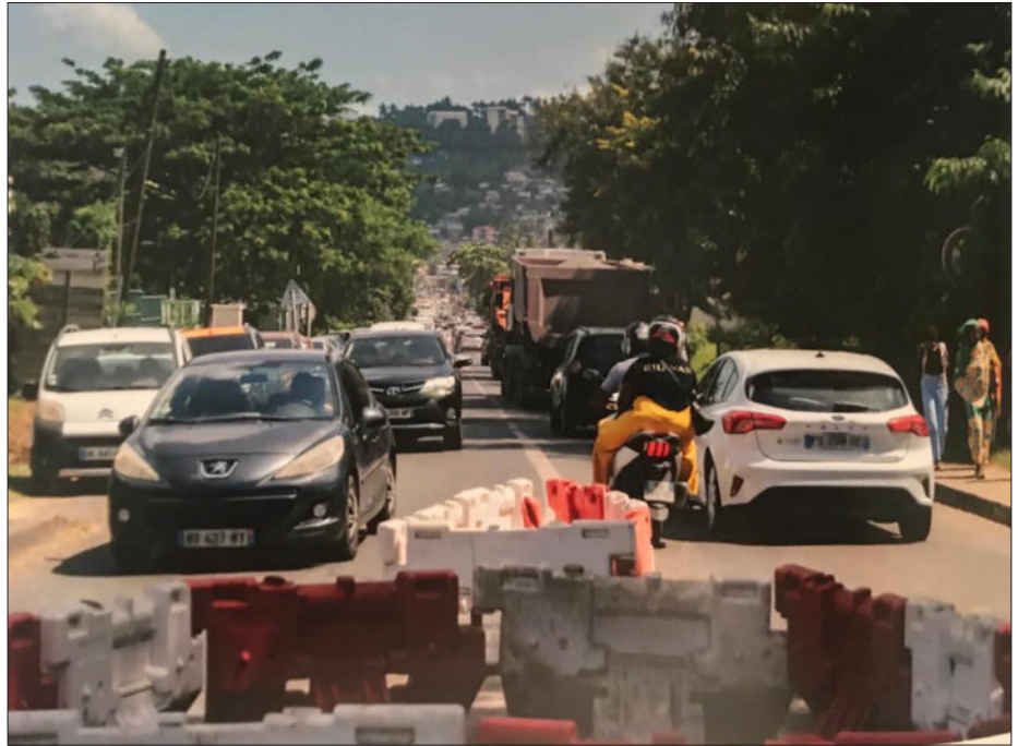
Durant les travaux la circulation sera fortement impactée
