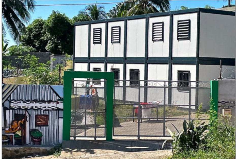
A Hamachaka, du linge sèche au soleil, preuve qu'une partie des habitants a intégré les logements
