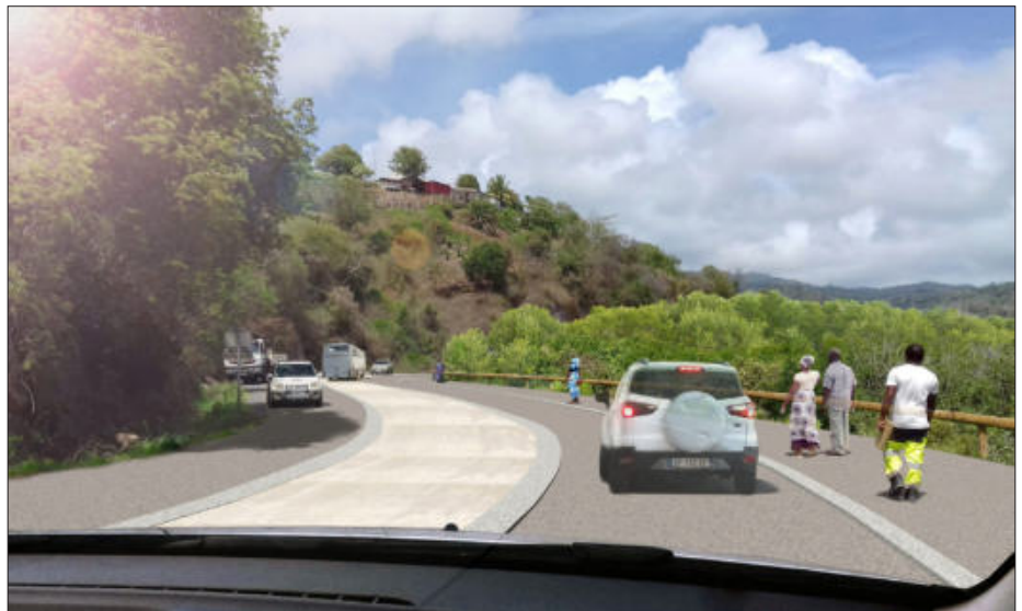
Tracé du projet Cadema®. Circulation terre-plein mental du Caribus, fluidification du trafic routier et bandes élargies dédiées aux cyclistes et piétons
