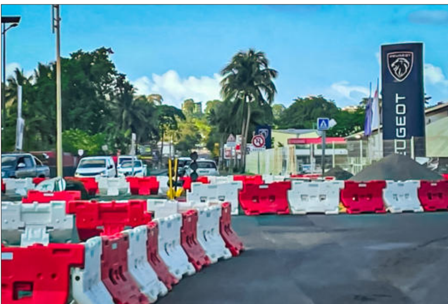
Des travaux mobiles tout le long des 2 parallèles du Grand-Kawéni
