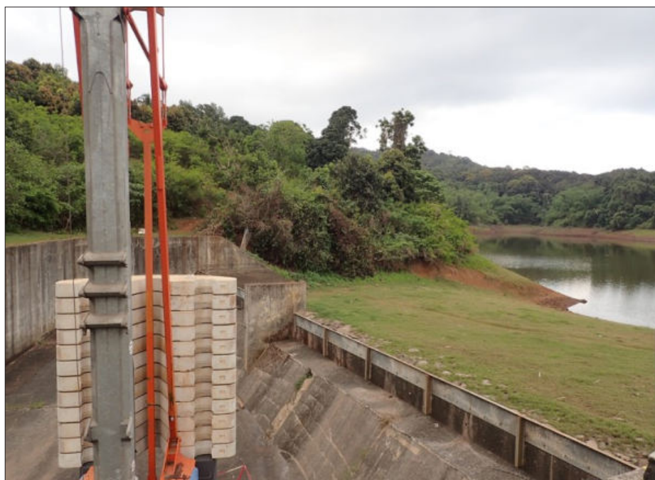
Les travaux de rehausse sur la retenue collinaire de Combani en 2022
