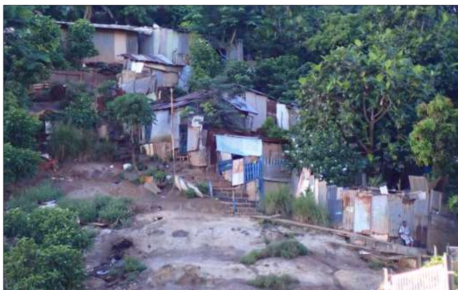
L'ensemble de cases en tôle de Talus 2 qui devait être démoli
