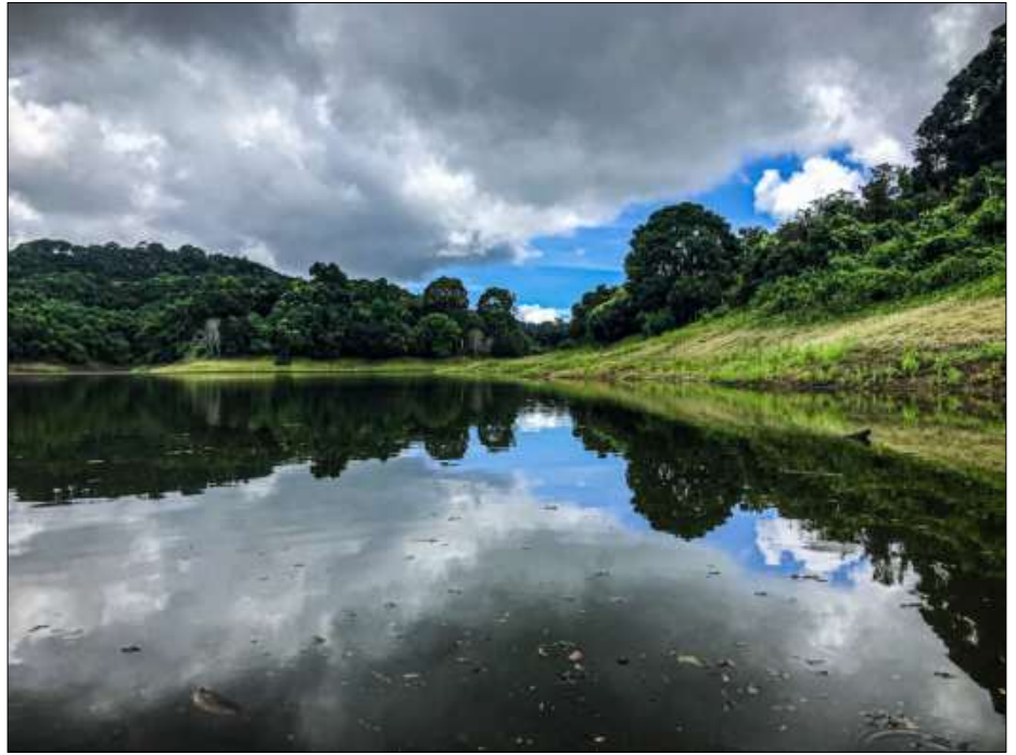
La retenue collinaire de Combani le 28 mars 2023
