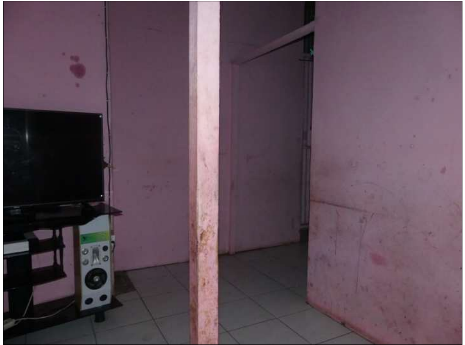
Présence de cloisons de séparation dans une des cases dont les équipements seront pris en charge ce mardi
