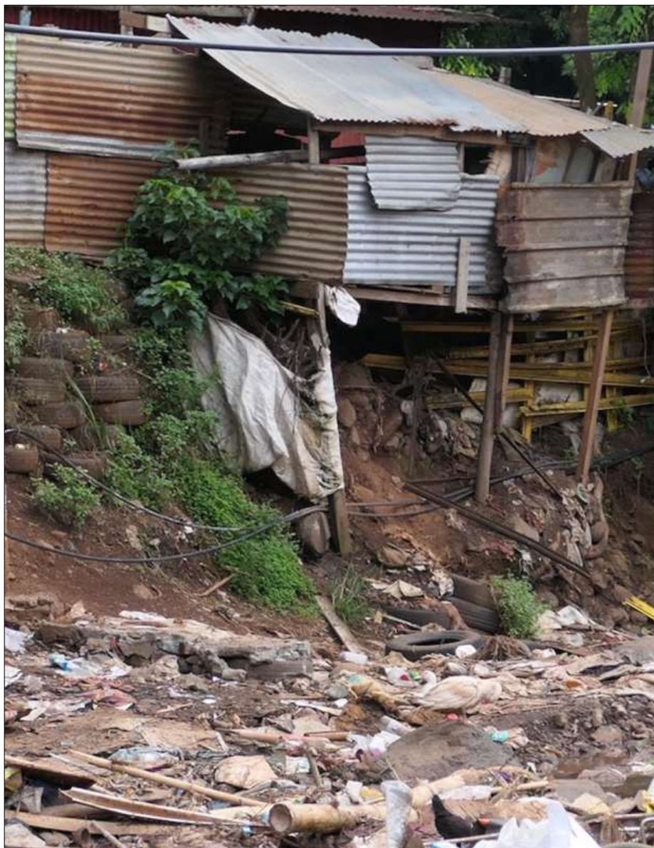
Une partie des cases en tôle insalubres sur les hauteurs de Kawéni
