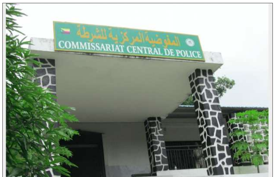
Siège du commissariat central de Moroni
